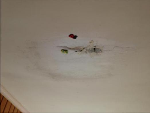
Foto N° 13. Filtraciones de humedad en cielos
