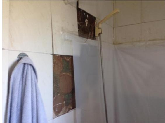
Foto N° 16. Filtraciones en baño, con desprendimiento de cerámica.
