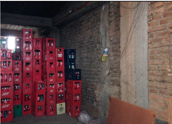
Foto N° 47. Bodega en primer piso al interior de la construcción
