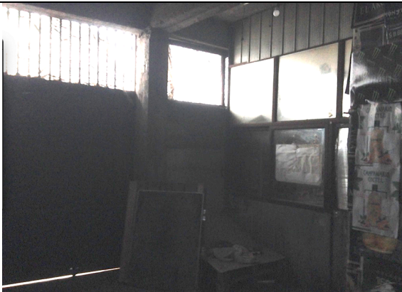
Foto N° 46. Bodega en primer piso al interior de la construcción
