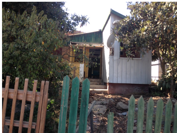
Foto N°13. Vista del frontis de la propiedad de autos. Nótese la inexistencia de puertas y ventanas .
