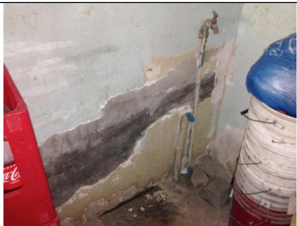
Foto N° 8. Muro en primer piso. Nótese las filtraciones existentes.
