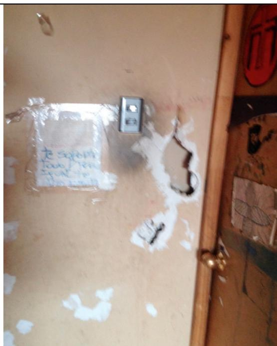
Foto N° 10 Puerta de acceso a dormitorio en segundo piso. Nótese tabiquería en mal estado
